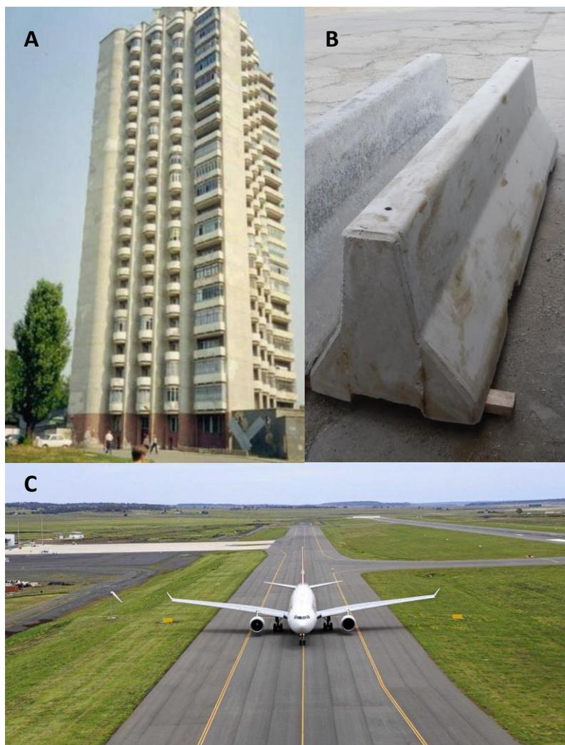
**Obr. 4: Příklady aplikace alkalicky aktivované vysokopecní strusky. 24-podlažní budova v Lipetsku (A); betonová svodidla v ŽPSV a.s. (B); letištní runway West Wellcamp Brisbane (C)**
